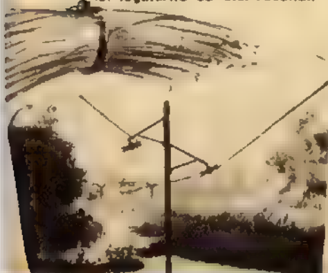
Funicular bicablu pentru transportul legăturilor de stuf recoltat.
